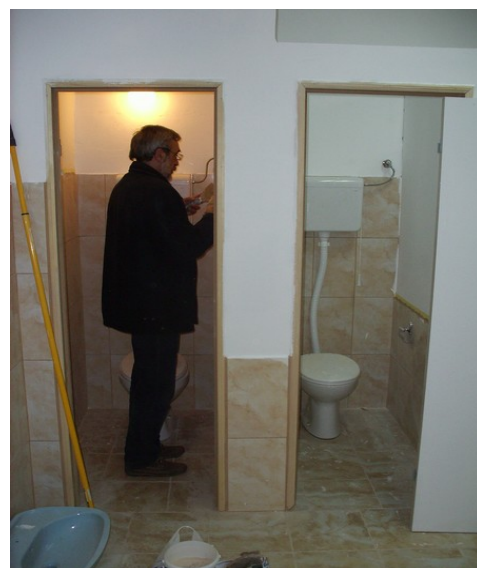
LAVORI IN FASE DI
