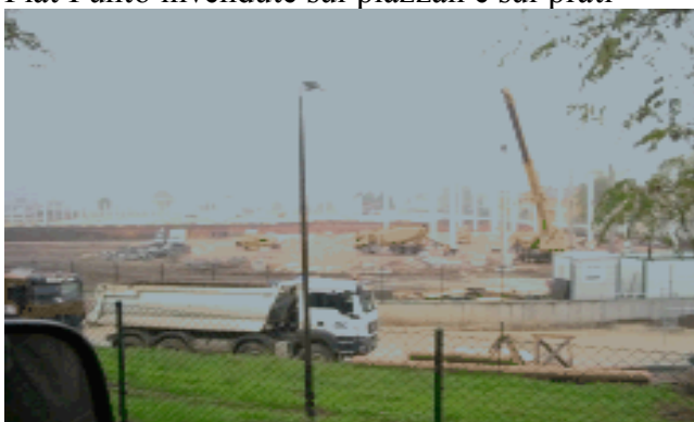
Lavori a Grosnica
