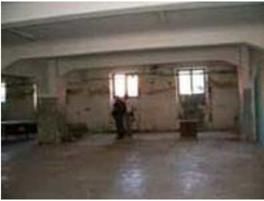
Lavori in corso a settembre 2007
