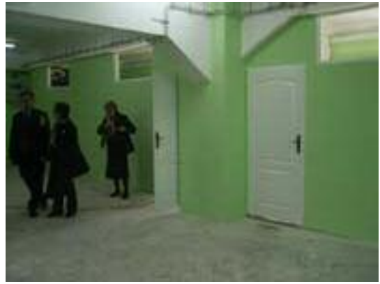
Lavori in corso a marzo 2008
