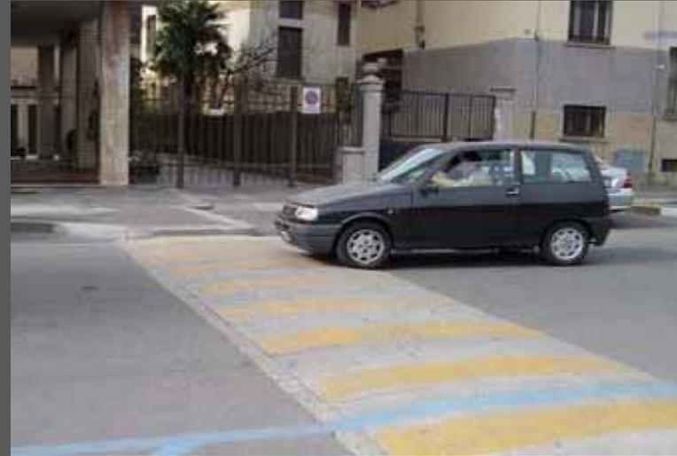
*Un dosso di rallentamento prefabbricato in materiale termoplastico, adatto a strade con limite di velocità di 50 km/h (a sinistra), e uno realizzato in opera in conglomerato cementizio, per strade con limite di velocità di 30 km/h*
