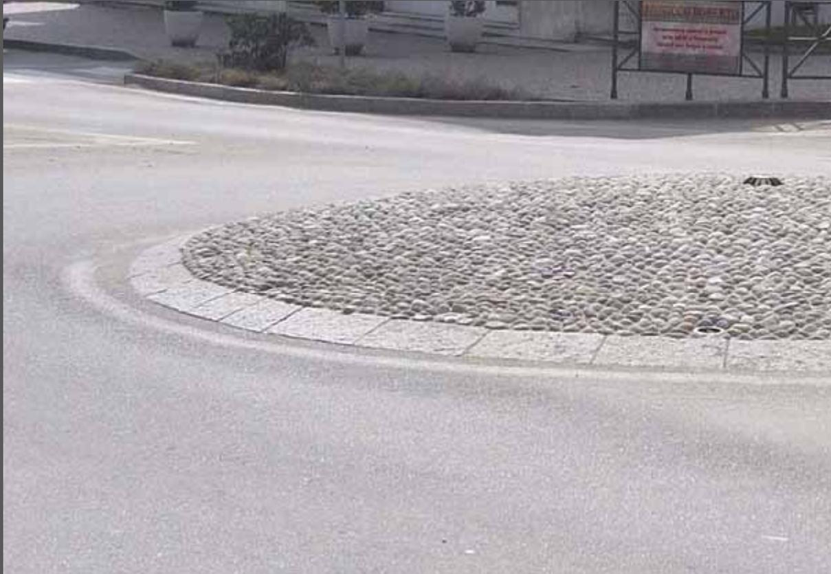
*Un'isola centrale completamente sormontabile,
