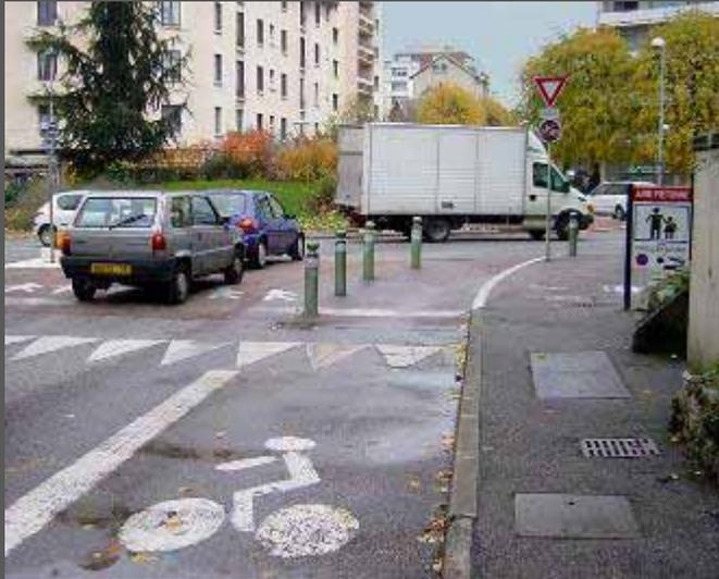
*esempio di rotatoria sicura per i ciclisti, in quanto la corsia ad essi destinata è ricavata all'esterno della corona giratoria.*
