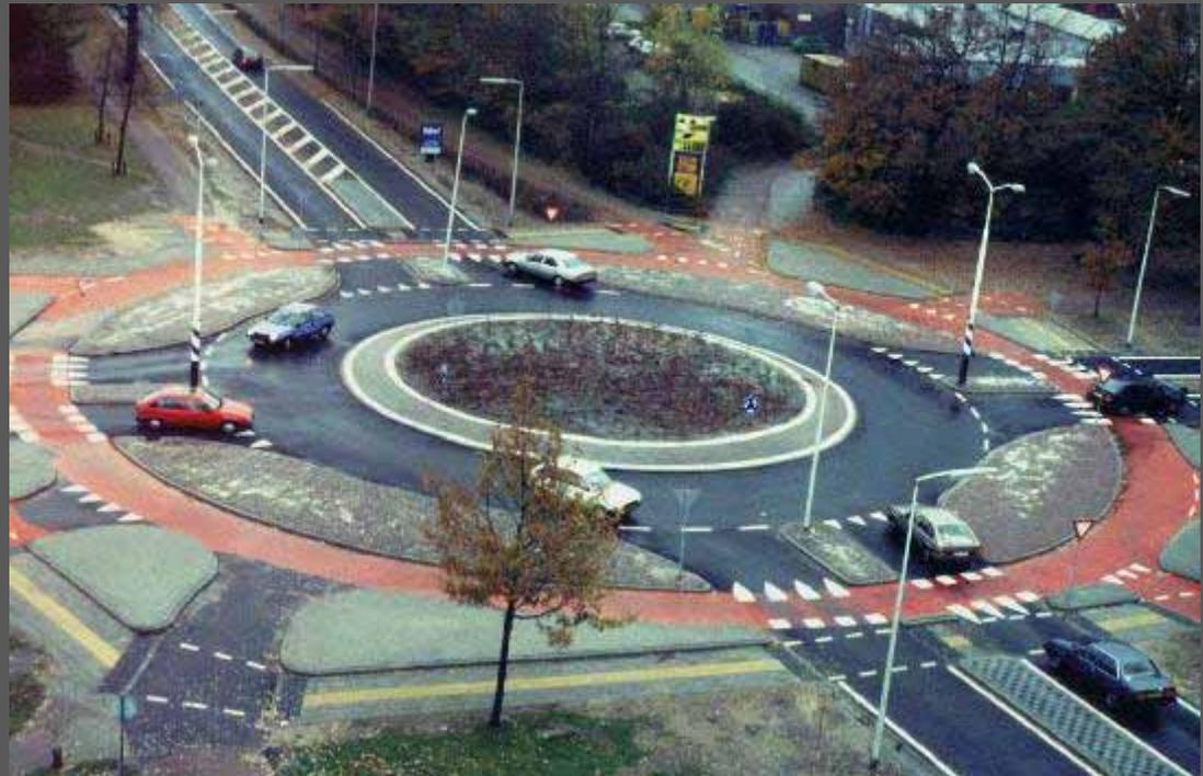
*Schema di rotatoria con pista ciclabile esterna e separata dall'anello veicolare, proposta dalle Norme sulle caratteristiche funzionali e geometriche delle intersezioni stradali*
