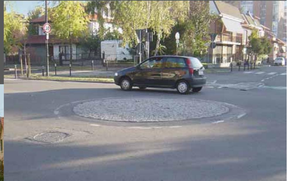
*minirotatorie con l'isola centrale parzialmente sormontabile con diametro dell'isola centrale inferiore ai 4 m.*
