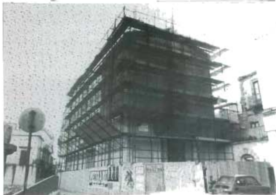
Chiesa di S. Paolo, Siracusa, in manutenzione
