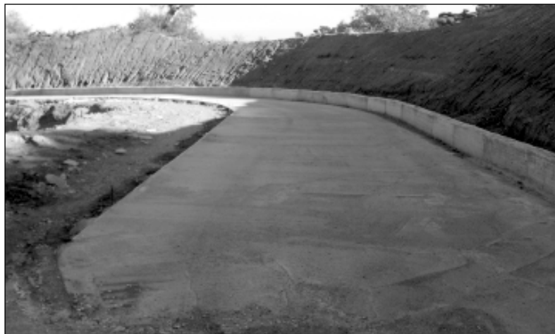
I lavori di sistemazione della strada di Frassia
