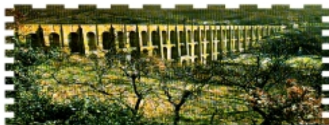
I Ponti della Valle, capolavoro ingegneristico del Vanvitelli
