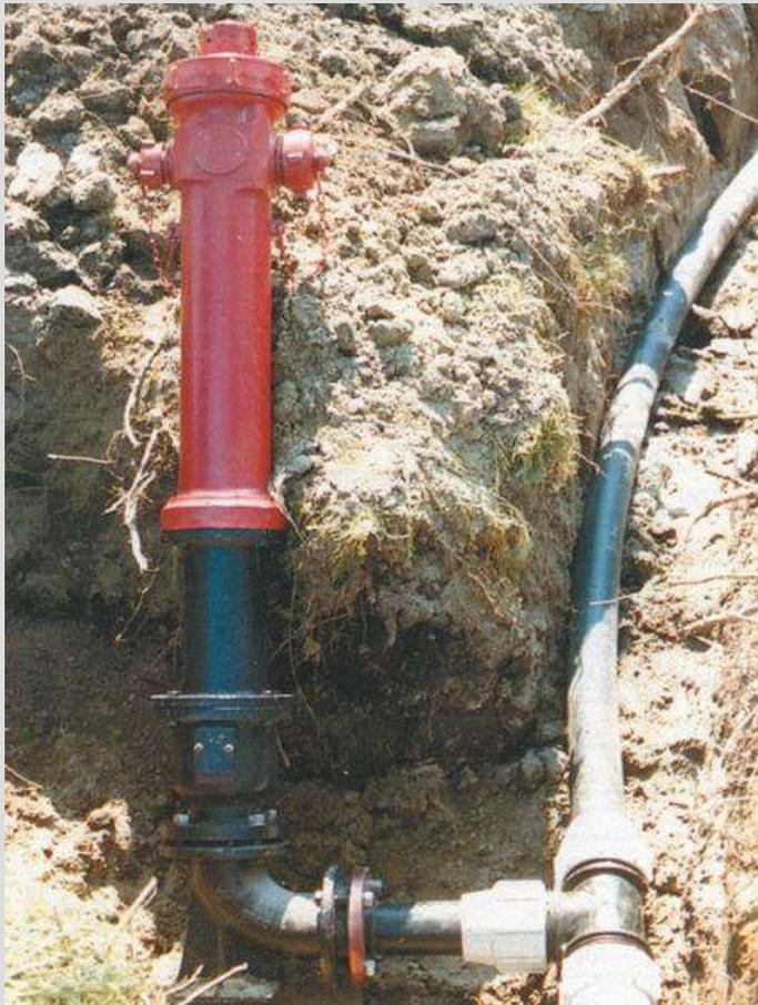
Apparecchiatura antincendio, permanentemente collegata a una rete di alimentazione idrica, costituita da una valvola alloggiata nella porzione interrata dell'apparecchio, manovrata attraverso un albero verticale che ruota nel corpo cilindrico, nel quale sono anche ricavati uno o più attacchi con filettatura unificata.
