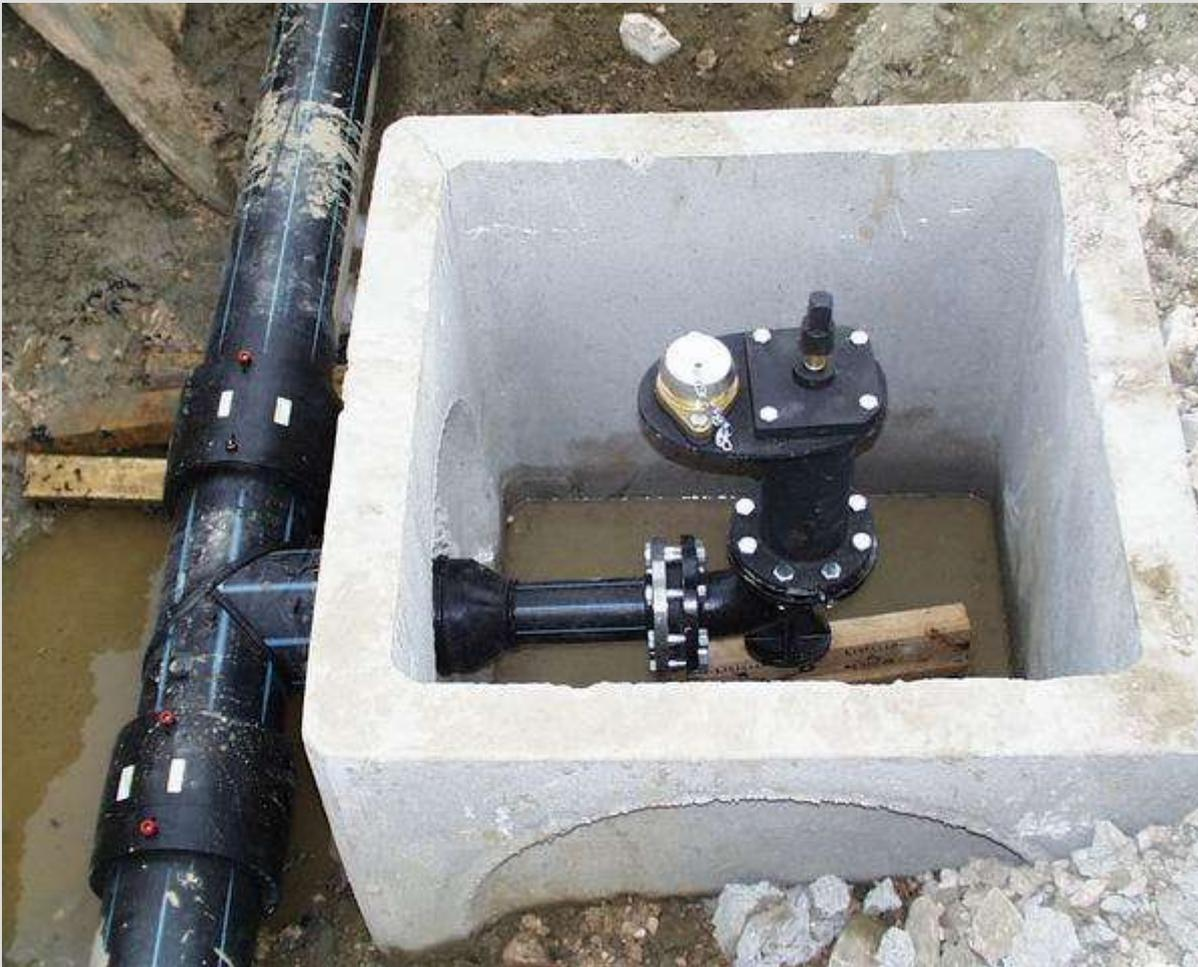
Apparecchiatura antincendio, permanentemente collegata a una rete di alimentazione idrica, costituita da una valvola provvista di un attacco unificato ed alloggiato in una custodia con chiusino installato a piano di calpestio.
