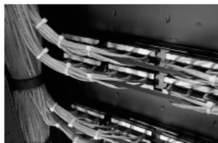
causa di eccessive curvature. Il permutatore dovrà essere dotato di una guida di sostegno e di ancoraggio dei cavi da terminare.
