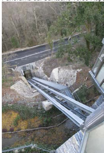
Il nuovo ascensore per le persone con difficoltà motorie
