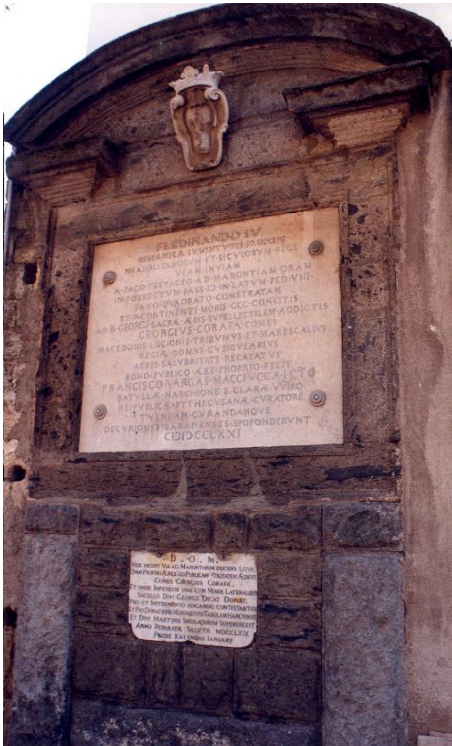
Fig. 6 – Lapide di G. Corafà che ricorda la costruzione del pendio dei Maronti, del gennaio 1769, e del Decurionato di Barano del 1771.
