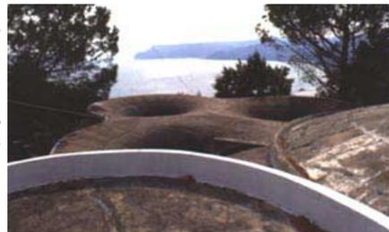
orditura di rete di acciaio intonacata con malta di cemento forma una struttura sottile a guscio, in mimesi interattiva con le corolle dei fiori selvatici locali.
