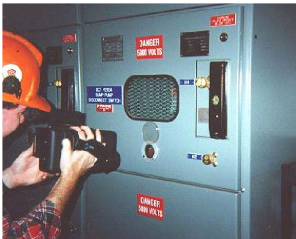
Figura 19 – Ispezione attraverso una finestra in Alluminio e Zaffiro.
