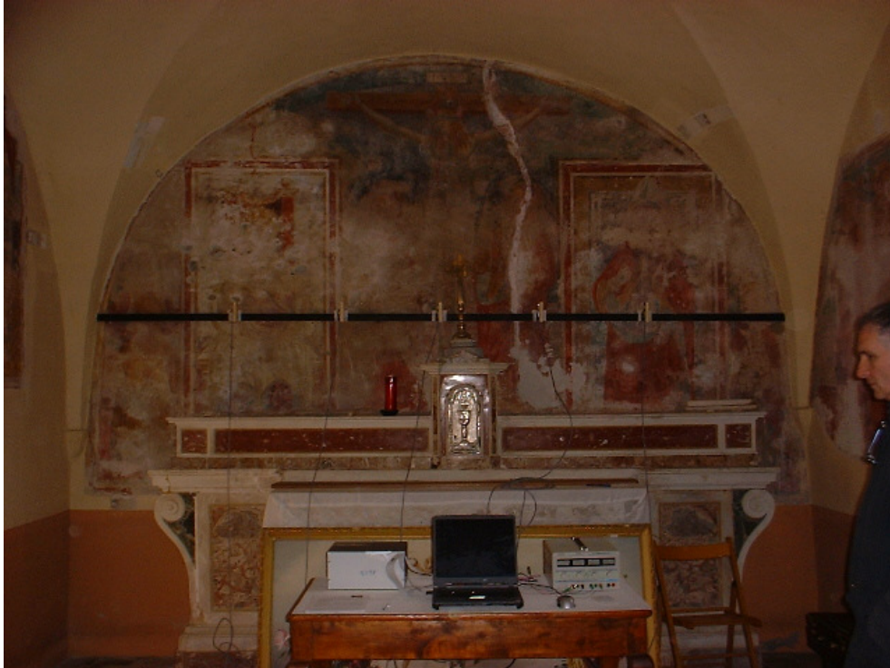
Figura 1: Disposizione degli accelerometri sulla catena
