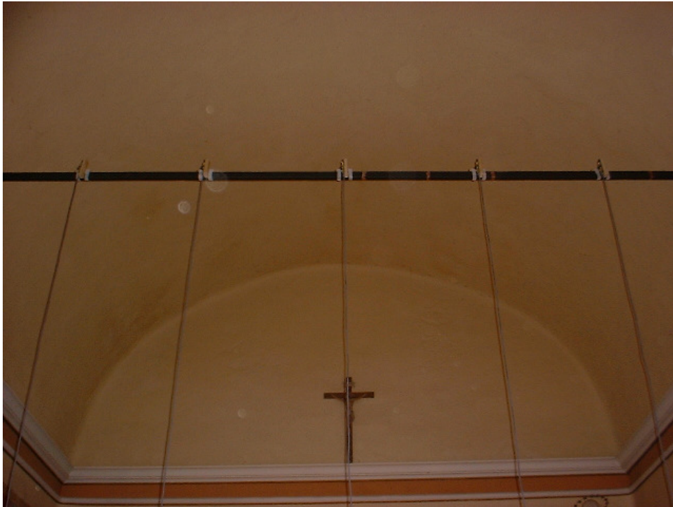
Figura 8: Fissaggio degli accelerometri
