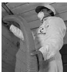
Figura 2 e 3 – Insufflaggio e Fiochi di cellulosa –
