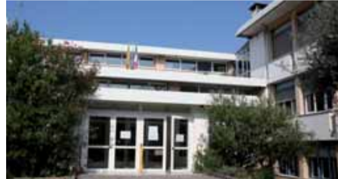
La scuola media, sede dell'Istituto Comprensivo di nuova costituzione. (sopra) Il ponte di Gattolè e la ristrutturazione collegata al piano di recupero della pescheria.
