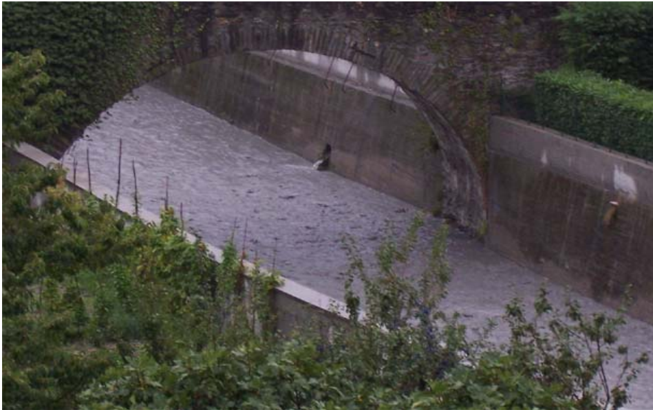
Fig. 9.1. Il torrente Cenischia alle ore 9:00 del 7 Settembre 2005. Si nota già una portata sostenuta (circa 40 \text{ m}^3 \text{ s}^{-1} )
