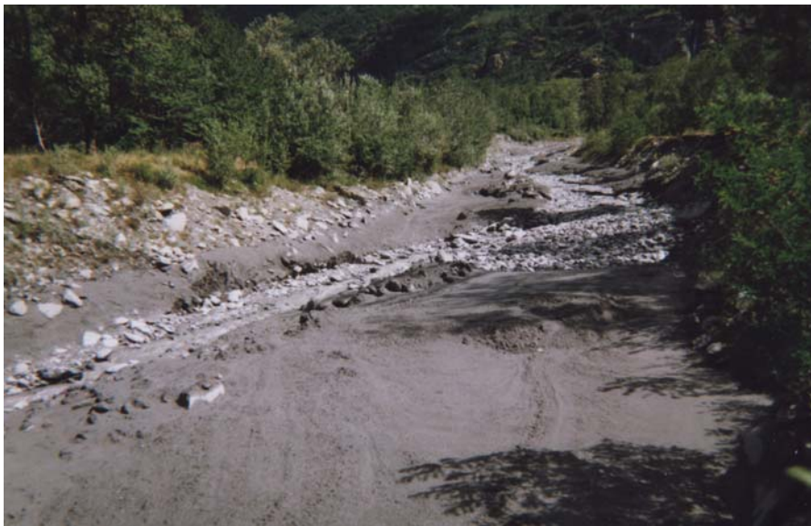
Fig. 8.30. Alveo del T. Marderello a monte del ponte della Strada Provinciale Susa – Venaus – Novalesa – Si nota il livello raggiunto dalla colata detritica; il sedimento è di natura sabbioso – limosa (Foto realizzata il 6 Agosto 2005).
