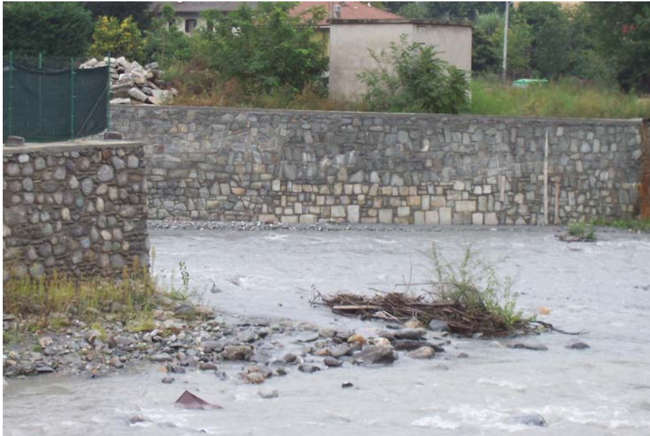
Fig. 6.28. Confluenza del Torrente Cenischia nella Dora Riparia (quota 485 m s.l.m.) – Recentemente riprogettata, ora presenta un angolo di incidenza di 30^\circ che limita le interazioni tra i livelli dei due corsi d'acqua.
