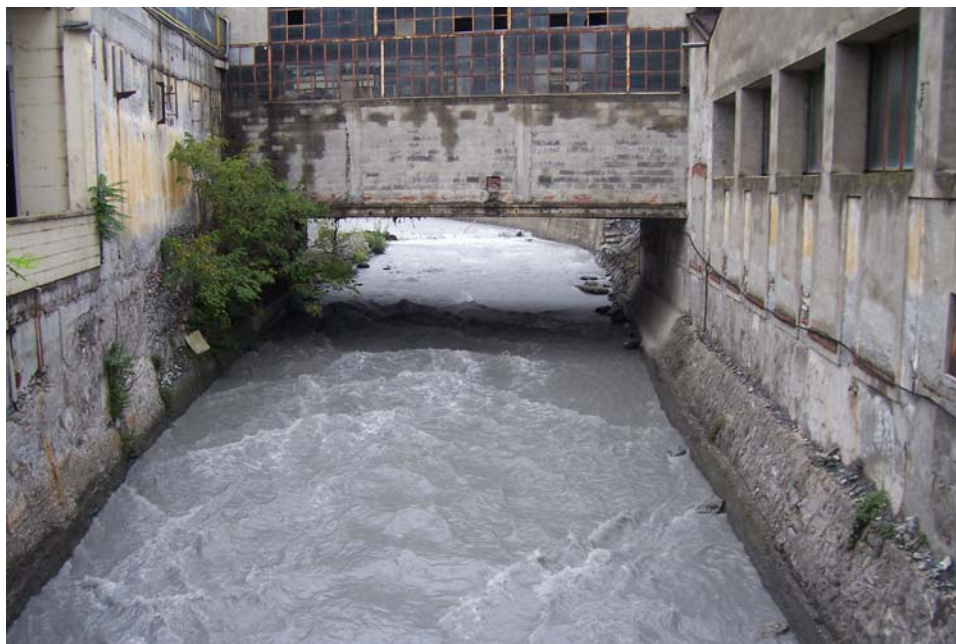
Fig. 6.30. Torrente Cenischia – Sezione critica per il transito della portata cinquecentenaria ( 440 \text{ m}^3 \text{ s}^{-1} ), costituita da un attraversamento privato e da un fabbricato.
