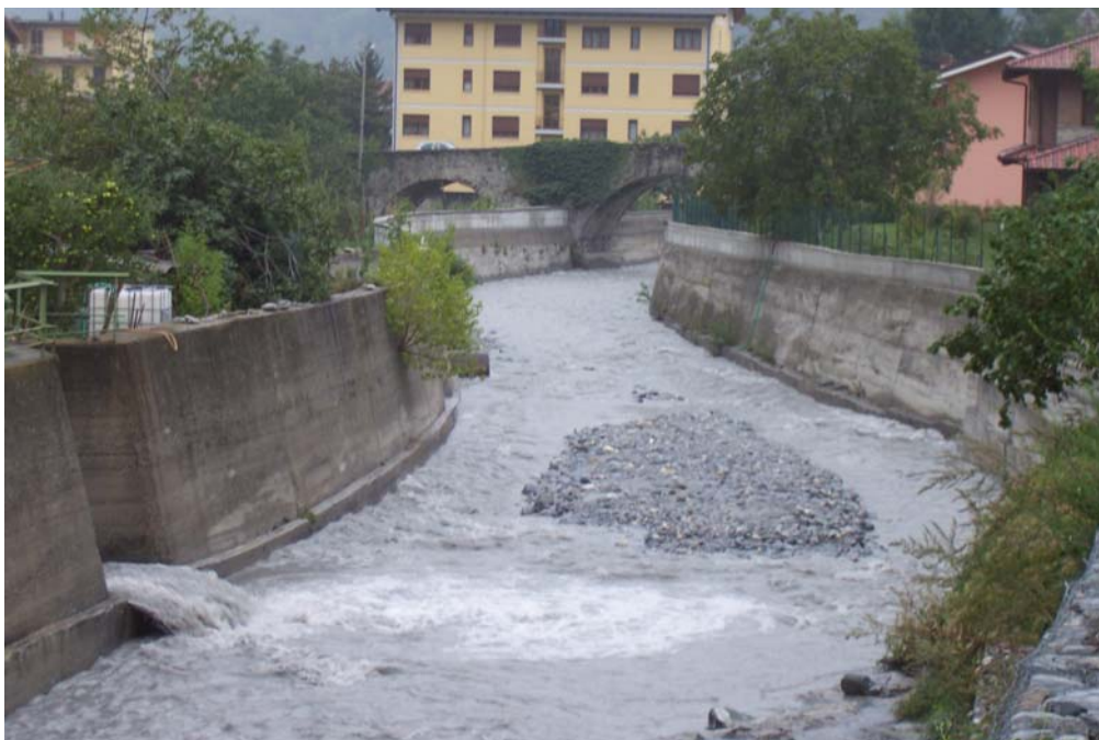
Fig. 6.33. Torrente Cenischia – Il Ponte Romano sullo sfondo presenta 5 arcate; oggi solo la arcata centrale, di luce maggiore, risulta disponibile per consentire il deflusso della piena.
