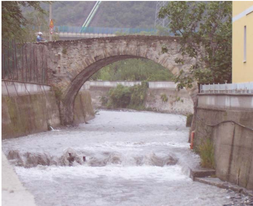
Fig. 6.32. Torrente Cenischia – La sezione del Ponte Romano vista da valle. Si nota la presenza di una briglia selettiva circa 50 m a valle della sezione, di recente costruzione. E' possibile altresì individuare il rialzo di entrambi gli argini di circa 90 cm per una lunghezza di 600 m.
