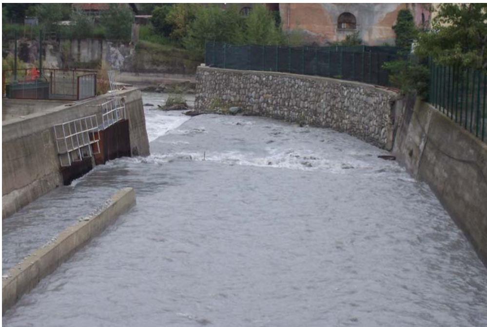
Fig. 6.28. Confluenza del Torrente Cenischia nella Dora Riparia (quota 485 m s.l.m.) – Recentemente riprogettata, ora presenta un angolo di incidenza di 30^\circ che limita le interazioni tra i livelli dei due corsi d'acqua.
