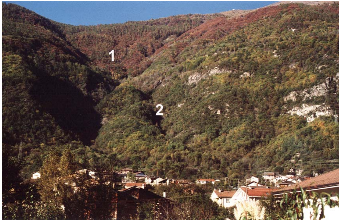
Fig. 4.20. Tratto terminale del Rio Supita visto da Venaus- L'alveo attuale (1), drena le acque dal sovrastante compluvio ben delimitato; è visibile la vecchia sezione di deflusso che, attualmente, non presenta alcun compluvio (2) (Fonte: Comune di Venaus, 2002)
