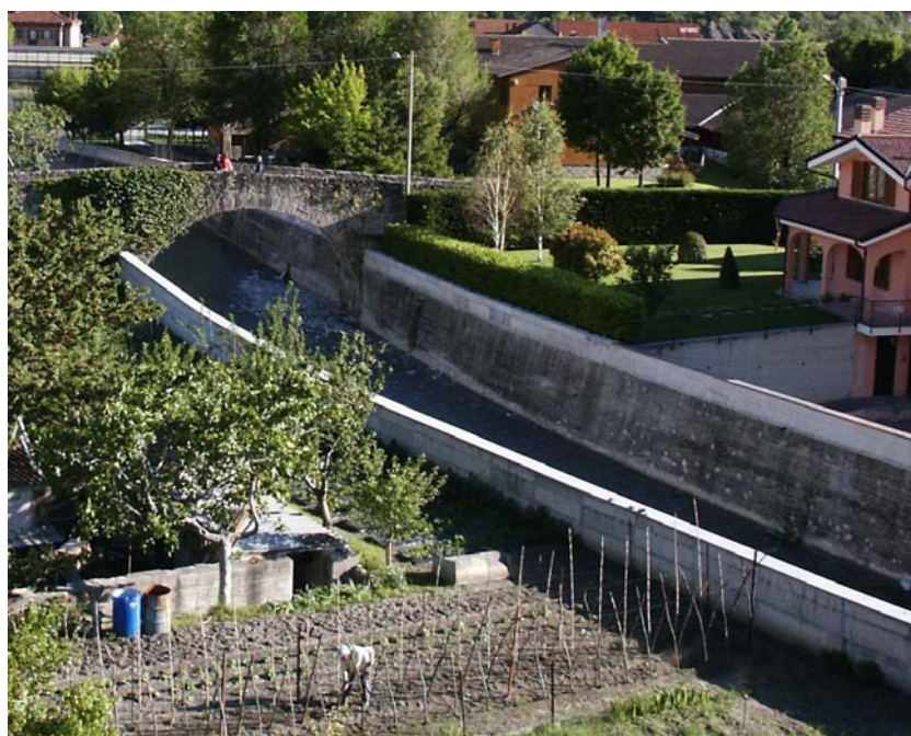
Fig. 4.31. Torrente Cenischia – Tratto terminale d'alveo in corrispondenza del Ponte Romano (Foto realizzata il 20 Agosto 2005).
