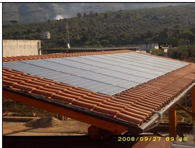
Impianto da 3,6 kW di picco nel Comune di Sonnino Scalo (LT) settembre 2008
