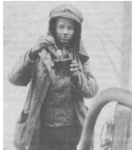
Fig. 9 – Un soldato testa il grado di clorazione dell'acqua potabile (26 a Divisione Fanteria; Lussemburgo, gennaio 1945).
