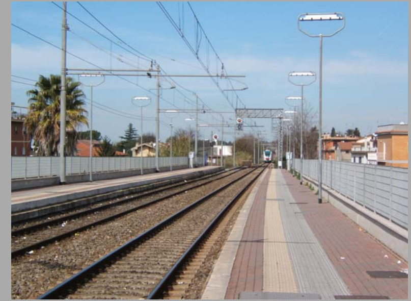
Marciapiedi di stazione
