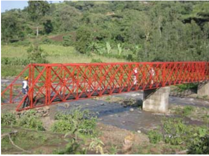
Il ponte sul fiume Sinkillé
