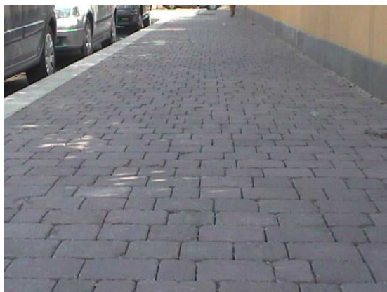
Figura 4: pavimentazione fotocatalitica in Via Settemetri a Roma
