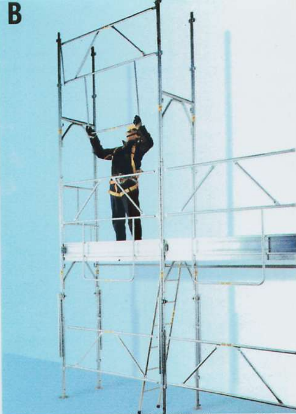
B) - inserimento del telaietto di parapetto nelle apposite boccole
