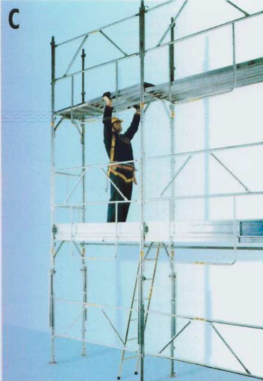
C) - Montaggio delle tavole metalliche fissando le chiavette di sicurezza al traverso dei telai
