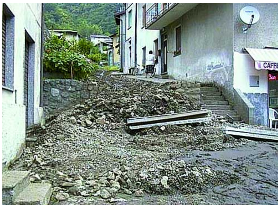
Scivolamento a valle di terreno e detriti.
