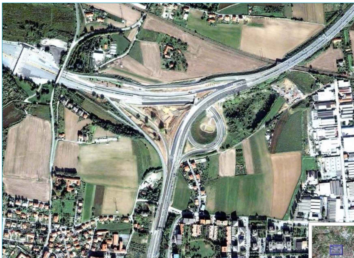
Figura 23: Il nuovo svincolo di Bruere della tangenziale di Torino
