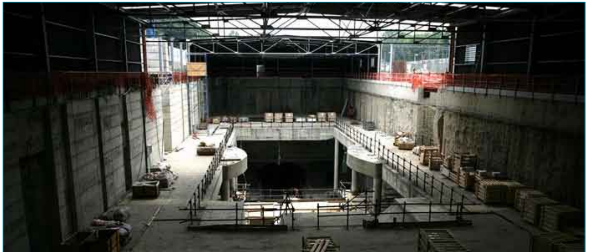
Figura 15: Metropolitana di Torino. La stazione di Porta Susa in costruzione.
