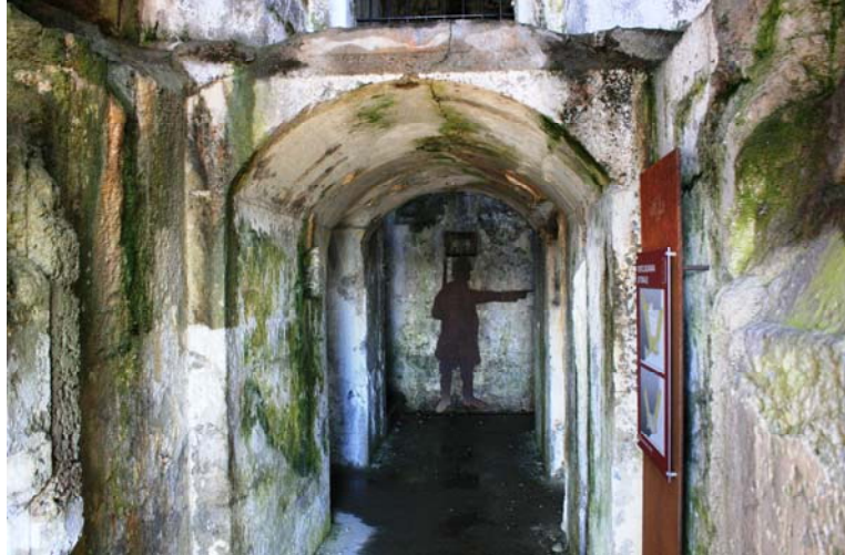
Particolare dell'interno del forte Zaccarana
