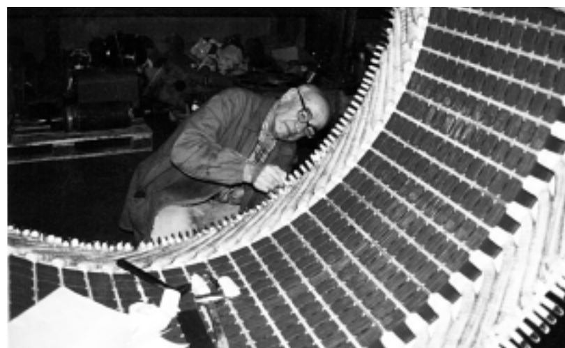
A Cuneo si è rifatta la parte elettrica.
