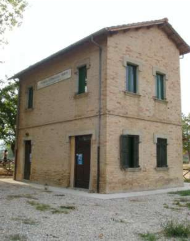
La ristrutturata Casa di guardia
