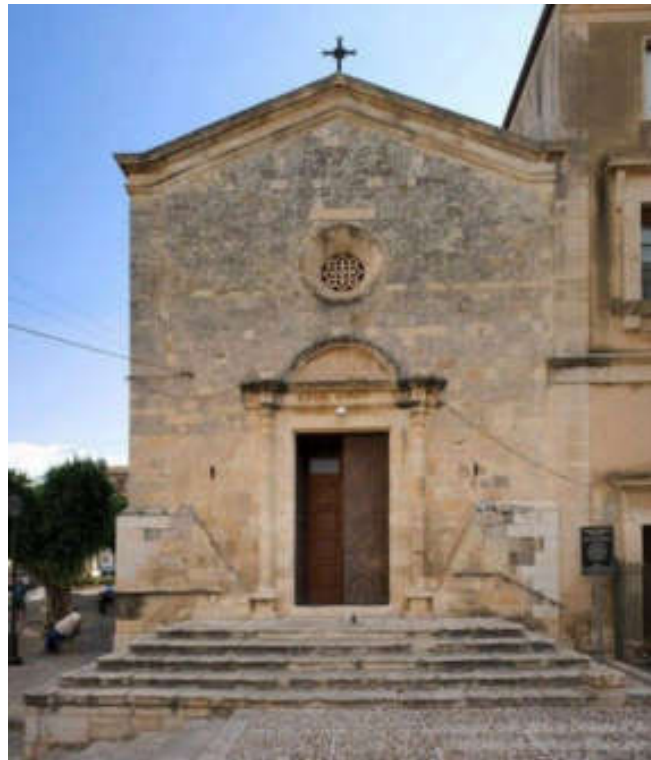
Facciata sud-ovest del Santuario
