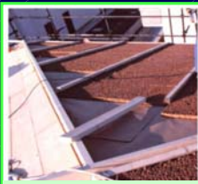
Pannelli di sughero 10 cm.copertura
