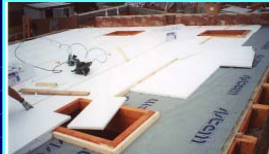
Isolamento Copertura: Pannelli di Polistirene
