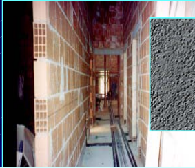
Mattoni laterizio forati Intonaco calce cemento
