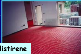
Isolamento Solaio contro terra: Pannelli di Polistirene
