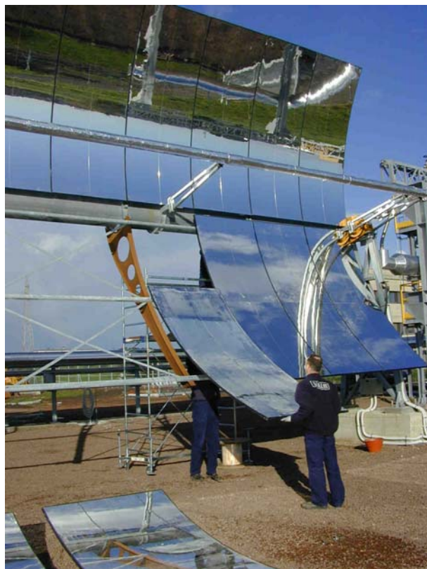
Fig. 16 - Montaggio degli specchi di prima generazione (Powerwall)
