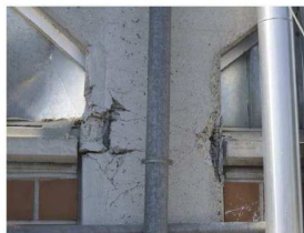
Danneggiamento del pilastro tozzo causa interazione con la tamponatura che non si sviluppa per tutta l'altezza
