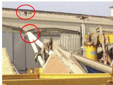
Inadeguatezza del vincolo trave-colonna con danneggiamenti locali del pilastro e rotazioni permanenti della trave in copertura
