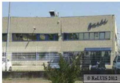
(a) Pannelli orizzontali di tamponamento con nessun danno visibile in seguito del sisma del 20 maggio e (b) collasso avvenuto degli stessi pannelli orizzontali a causa del sisma del 29 maggio
