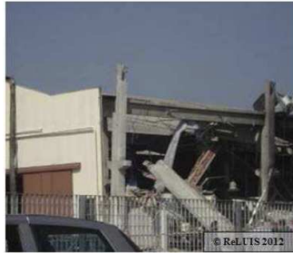
Collasso globale dell'edificio: perdita di verticalità del pilastro
