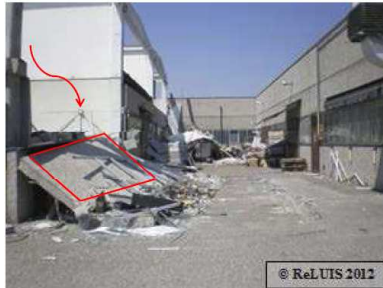
(a) Collasso imminente pannelli orizzontali di tamponamento a causa del sisma del 20 maggio e (b) collasso avvenuto degli stessi pannelli orizzontali a causa del sisma del 29 maggio
