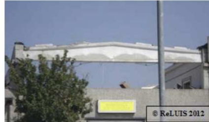
Dettagli profili slabbrati o disconnessi in corrispondenza del pilastro
