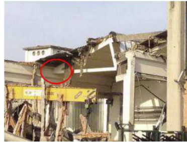
Inadeguatezza del vincolo trave-colonna con danneggiamenti locali del pilastro e rotazioni permanenti della trave in copertura
