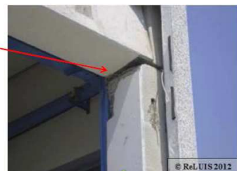
Inadeguatezza del vincolo trave-colonna con danneggiamenti locali del pilastro e rotazioni permanenti della trave in copertura
