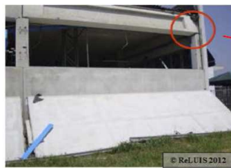
Inadeguatezza del vincolo trave-colonna con danneggiamenti locali del pilastro e rotazioni permanenti della trave in copertura
