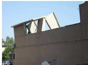
Perdita di appoggio di elementi di copertura a shed (a) particolare collegamento copertura-trave (b)
