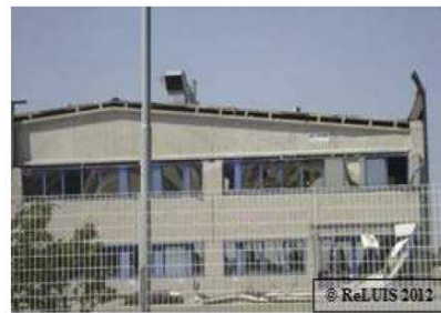
(a) Pannelli orizzontali di tamponamento con nessun danno visibile in seguito del sisma del 20 maggio e (b) collasso avvenuto degli stessi pannelli orizzontali a causa del sisma del 29 maggio
