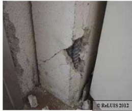
Danneggiamento del pilastro tozzo causa interazione con la tamponatura che non si sviluppa per tutta l'altezza
