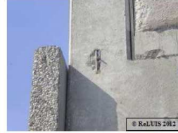
(a) Collasso imminente pannelli orizzontali di tamponamento a causa del sisma del 20 maggio e (b) collasso avvenuto degli stessi pannelli orizzontali a causa del sisma del 29 maggio
