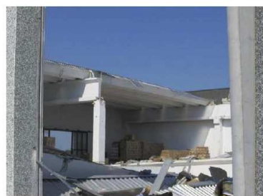
Perdita di appoggio di elementi di copertura a shed (a) particolare collegamento copertura-trave (b)
