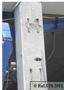
Dettagli profili slabbrati o disconnessi in corrispondenza del pilastro
