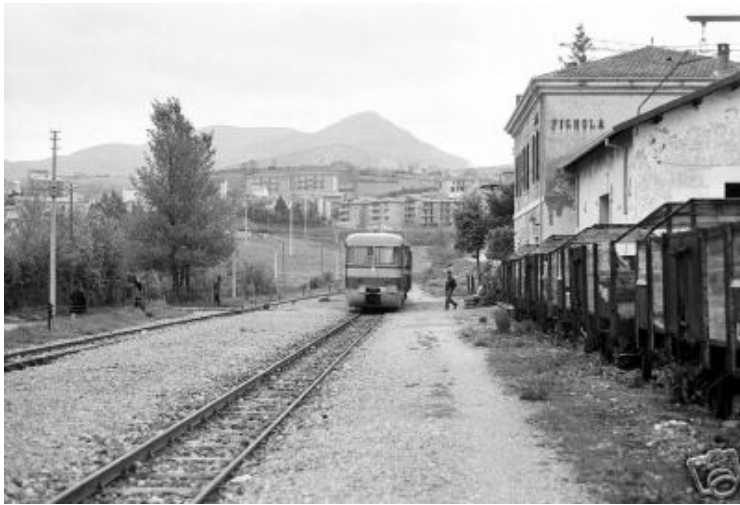
Pignola: Casello ferroviario, ora dismesso
