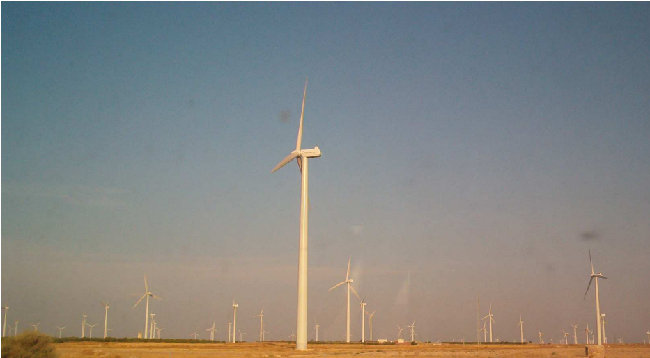
Centrale per la produzione di energia eolica
