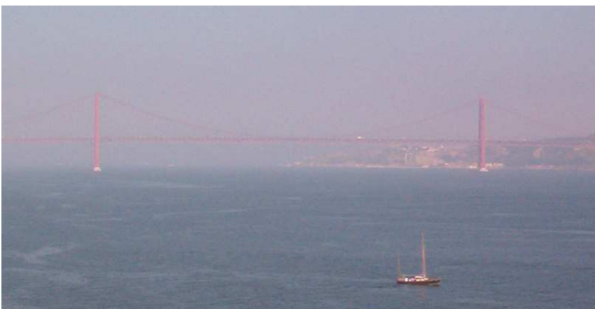
Ponte XXV aprile a Lisbona – sul fiume Tejo
