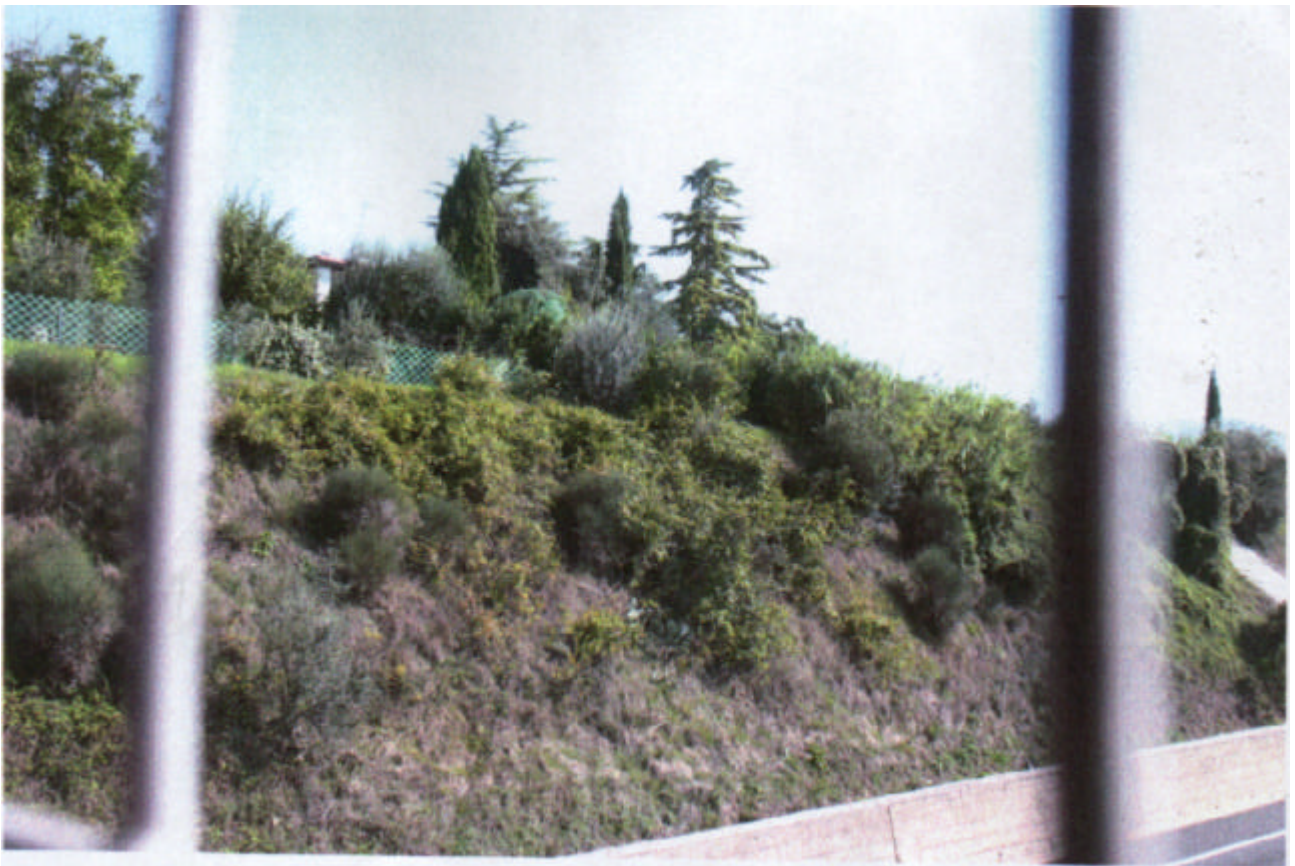
Foto n. 11 – edifici a monte dell'autostrada tra i km 3+600 e 4+150
