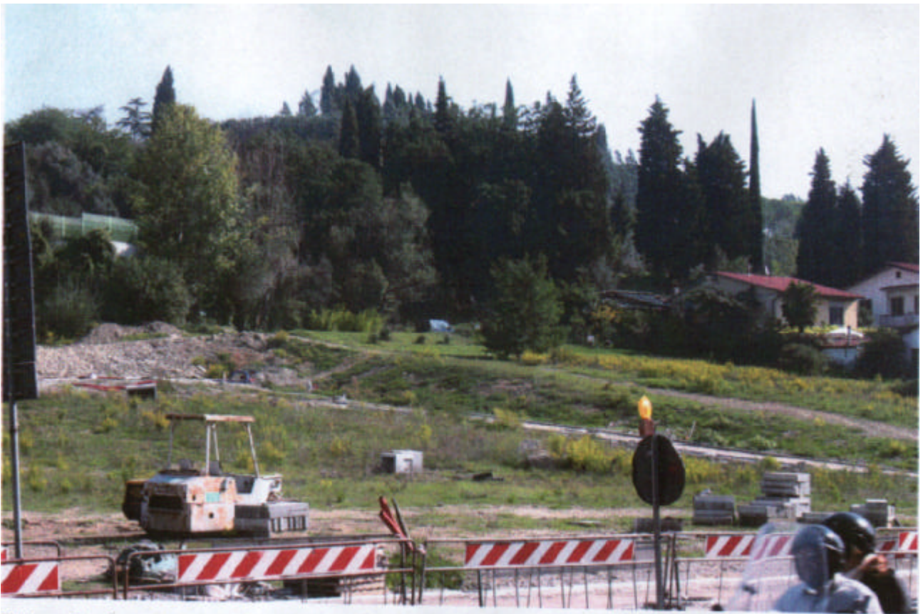
Foto n. 5 – incuneamento dell'autostrada nell'abitato
