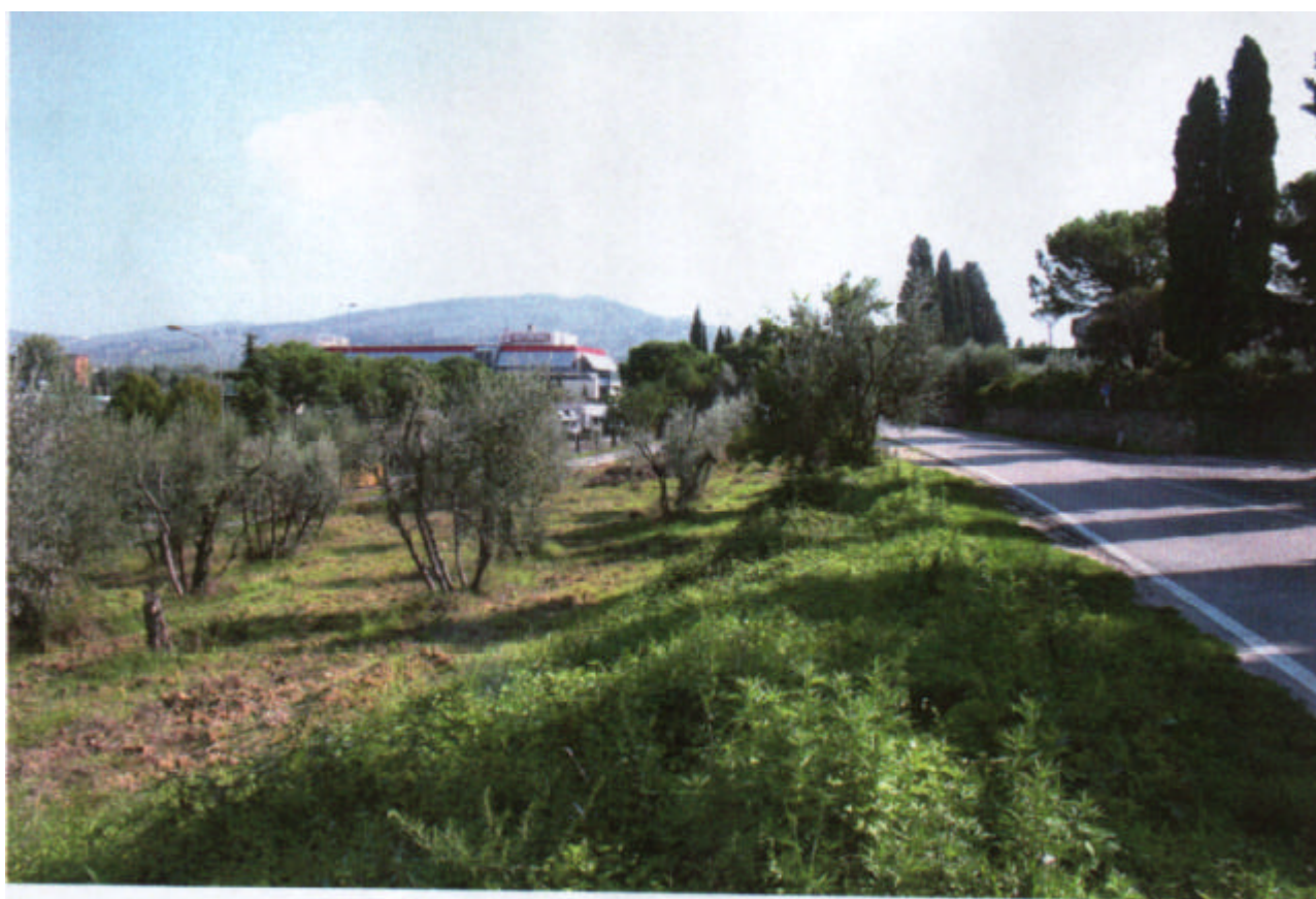
Foto n. 9 – zona di colmata in prossimità dell'area di servizio
