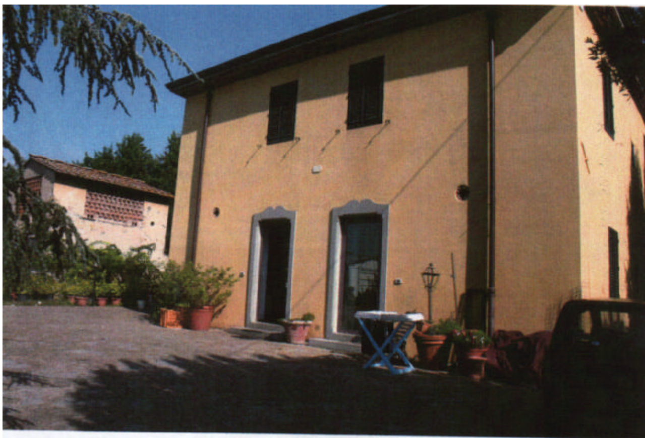
Foto n. 2 – edificio da demolire sezz. 141/142
