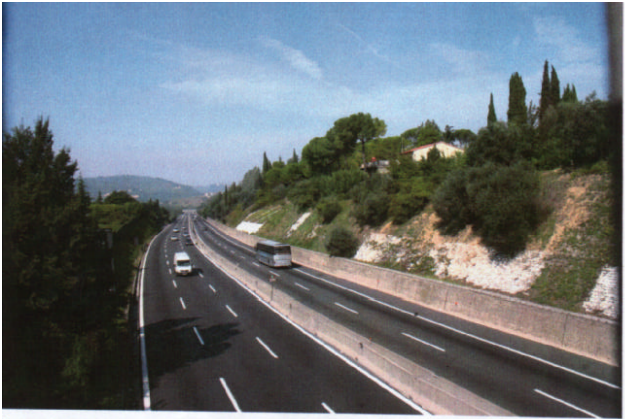
Foto n. 10 – edifici a monte dell'autostrada tra i km 3+600 e 4+150
