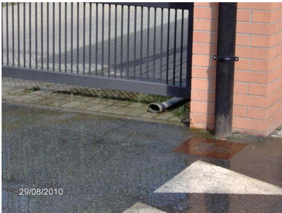
FOTO 2 – Abitazione costruita 3 anni fa in via Montegrappa n. 30. Hanno dovuto dotarsi di 4 pompe che scaricano in permanenza l'acqua che si forma nelle cantine, anche quando non piove, perché l'acqua proviene anche dalle falde molto alte. I condomini sono in causa con il costruttore.
