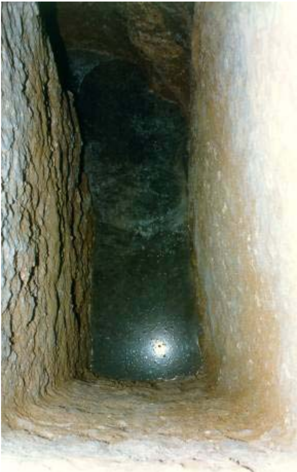
Fig. 10 Pozzo a pianta rettangolare da senia
