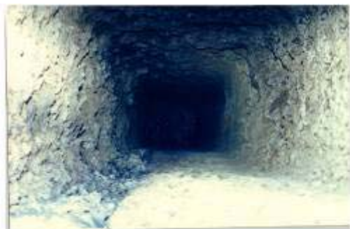
Bocca quadrata di pozzi idrico in Via delle Balate (Albergheria)
