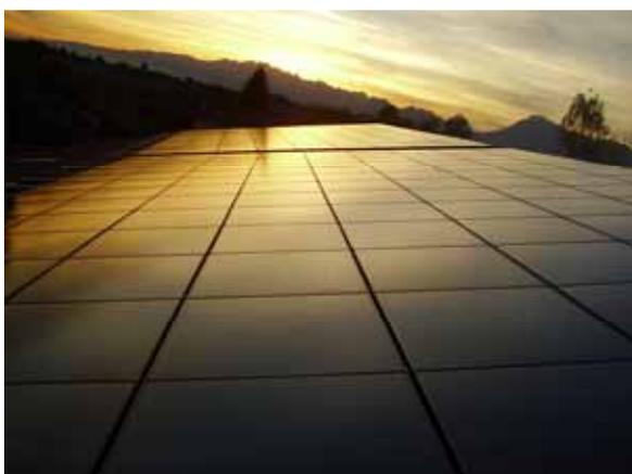
L'**Azienda Vinicola Vicentini Orgnani**, della provincia di Pordenone, ha deciso di far installare sul tetto a falda dell'edificio principale un impianto da **19,89 kWp**, costituito da **234 pannelli fotovoltaici tandem** firmati **Sharp**.
